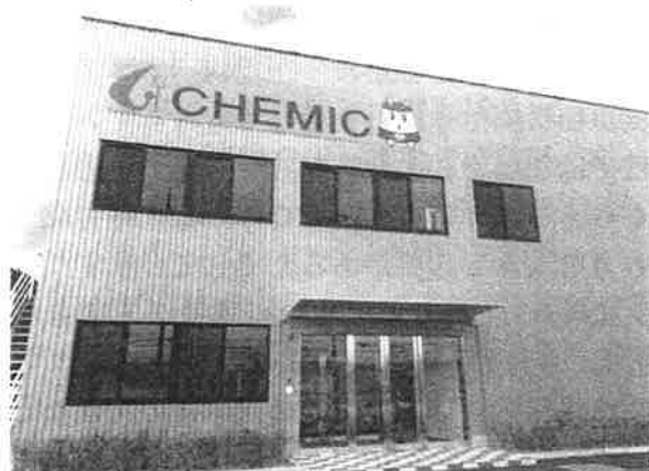
写真2 和歌山県橋本市の新本社・工場
